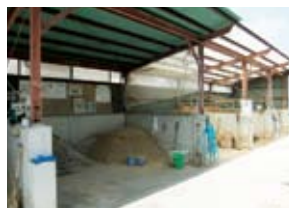
写真3 クルクル工場の堆肥舎
