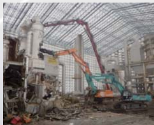
解体中 (2013年10月31日撮影)
