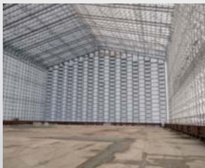
解体後 (2013年11月25日撮影)
