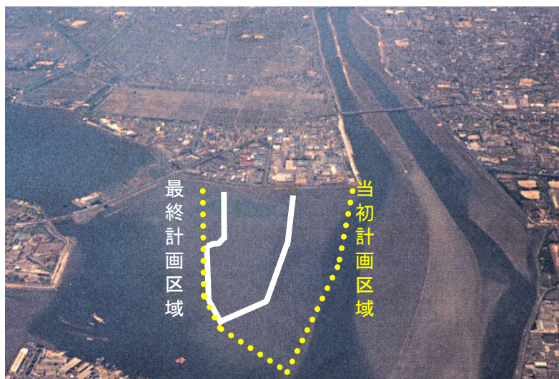
写真－1 名古屋港西一区埋立事業
