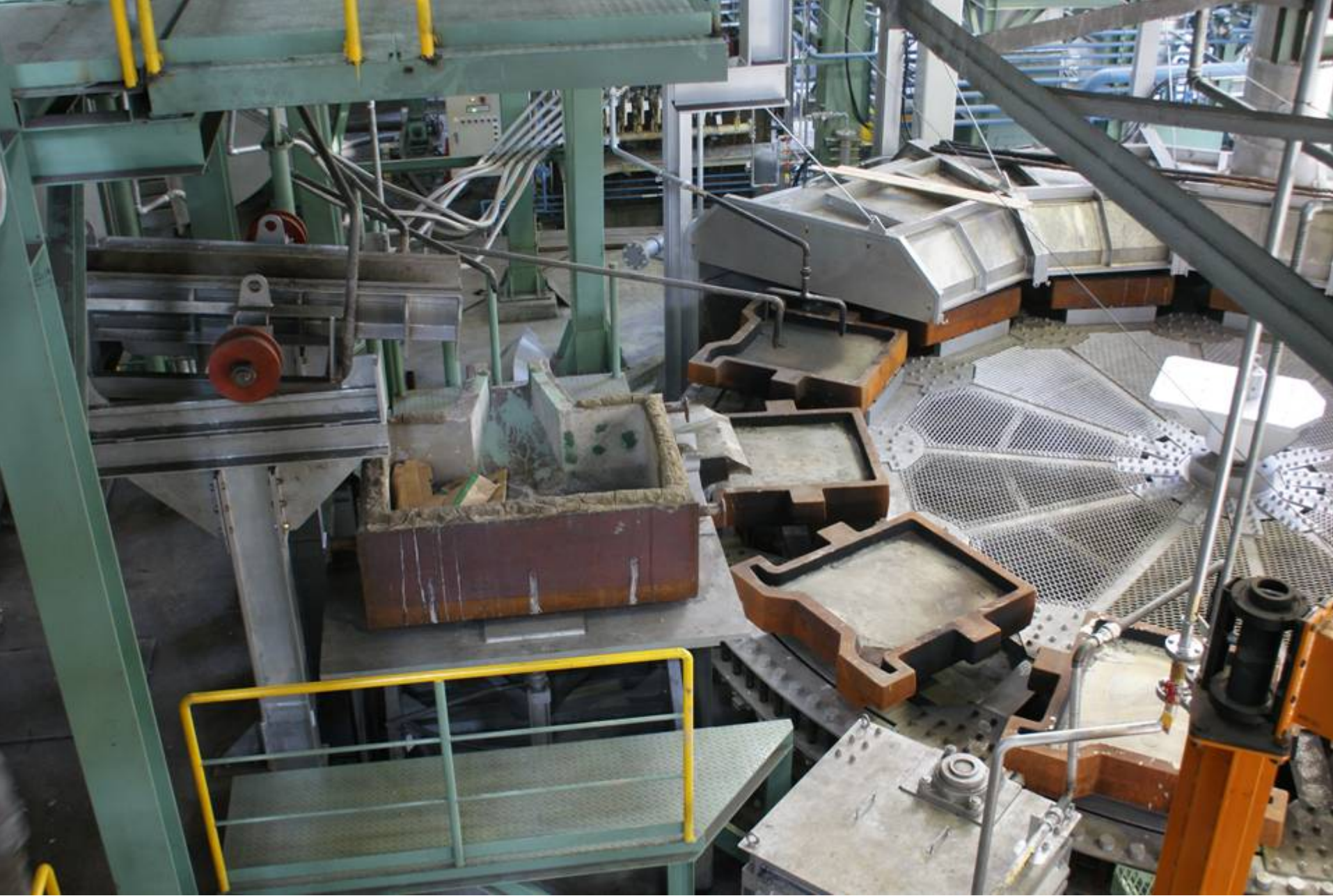
銅リサイクルのアノード鑄造機
