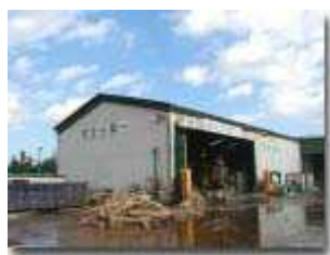
チップ化設備
