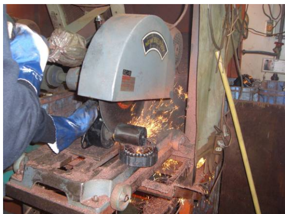
ロータ取り外し
