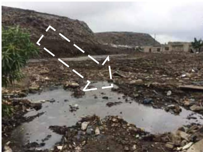
2/19夜の降雨が引き金となった処分場西縁部の崩壊崖。高さは約30mであり、5年前から、利用されていない。崩壊した家屋及び廃棄物は崩落発生後に現地当局により撤去済み。
