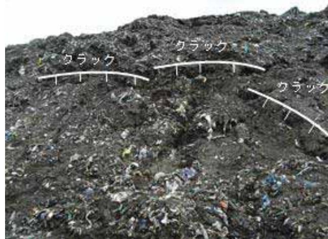
崩壊崖に発生した2次クラック。再崩壊の可能性を示す。しかし、前回崩落した廃棄物により、周辺道路を含む平坦な部分が広がっており、仮に再崩落しても、この平坦な部分である程度吸収できるのものと考えられる。
