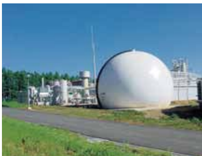
写真9 バイオマスパワーしずくいし
