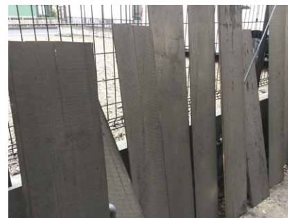
写真8 真っ黒の天井板 天井裏側
