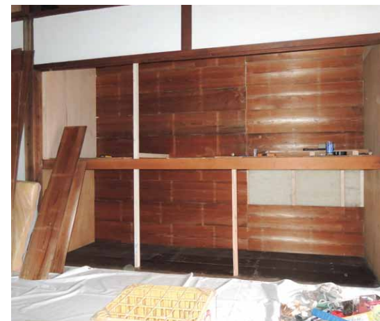
写真10 キレイになった元天井板を断熱後の押し入れの壁に使う
