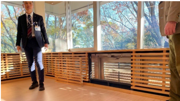
図5：換気窓（自然換気）
