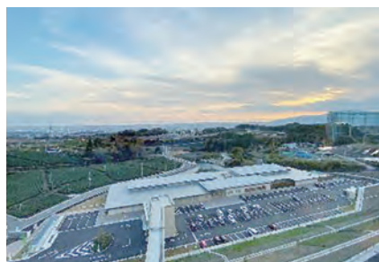
写真1 循環啓発棟と駐車場
