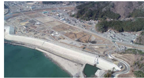
写真2 釜石市片岸地区の防潮堤 2) 高さ14.5m、延長0.8km 2020年3月撮影
