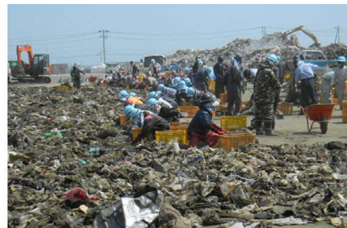
写真1 東松島方式による仮置場での選別作業の様子。徹底的な分別により、高いリサイクル率の実現と処理費の削減に寄与することから、現在、注目されている取り組みの一つ。(鈴木氏)
