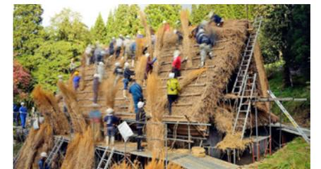
写真1 白川郷の結による屋根の葺き替え（提供：岐阜県白川村役場）
