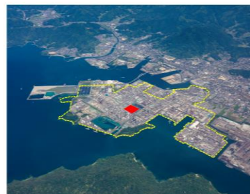
南陽事業所全景(中央の赤塗部が発電所新設予定地)
