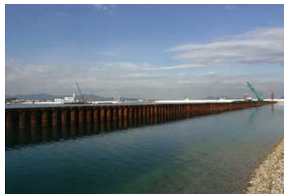
鋼矢板遮水壁
