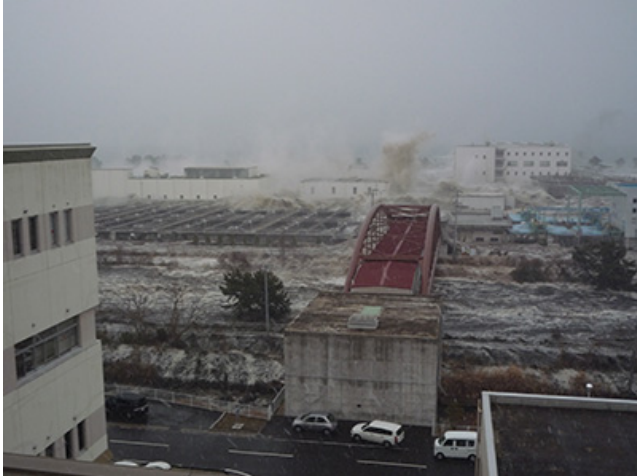
津波にのまれる南蒲生浄化センター
