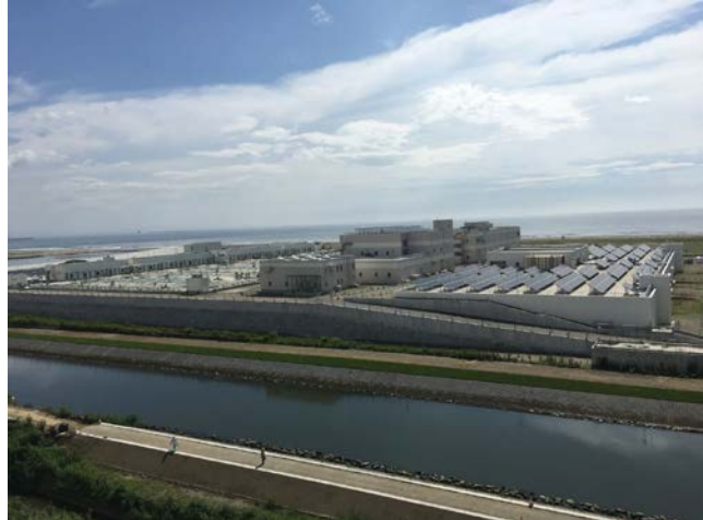
復旧後の南蒲生浄化センター
