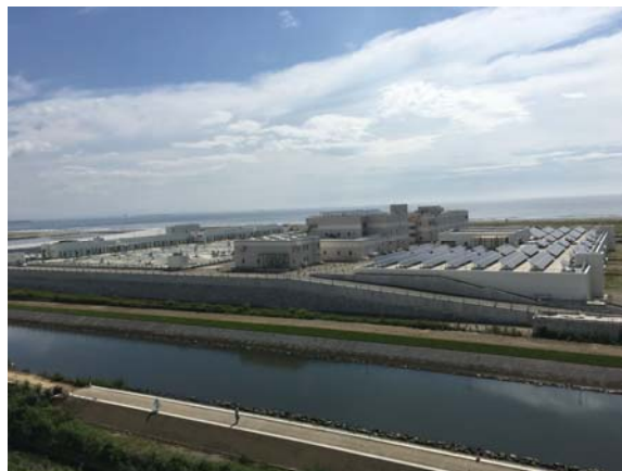
復旧後の南蒲生浄化センター
