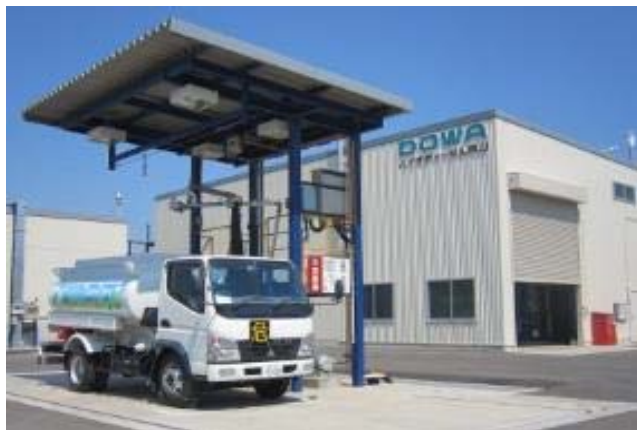
廃食用油のバイオディーゼル燃料化施設
