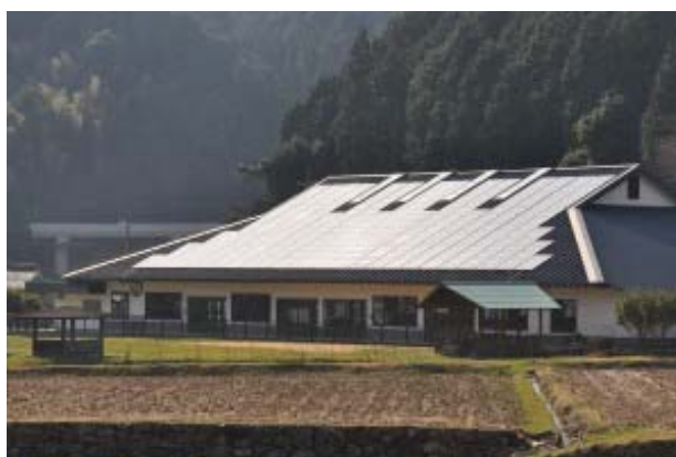
太陽光発電所
