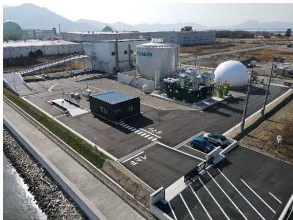
食品廃棄物メタン発酵処理によるバイオガス発電施設
