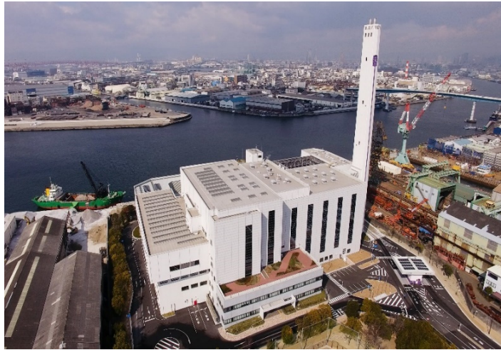
プラント外観(住之江工場資料より)
