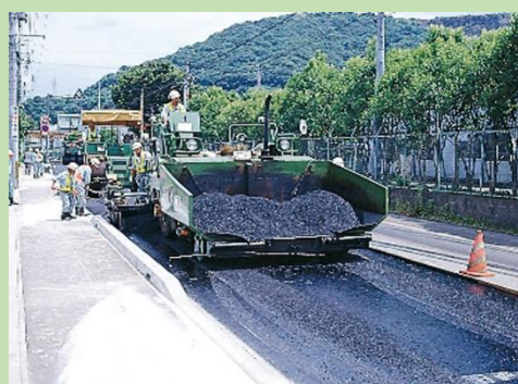
アスファルト舗装
