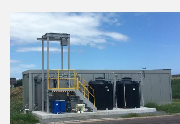
福岡県筑上町で、し尿・浄化槽汚泥を原料として製造されていた液肥について、窒素成分を約17倍に濃縮できるしくみを構築しました。
