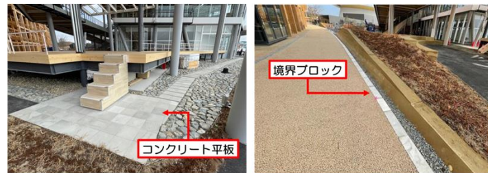
適用したコンクリート平板と境界ブロック
