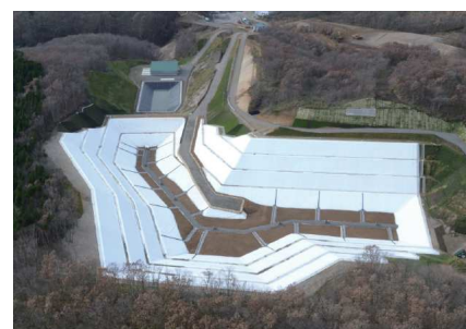
図 1 最終処分場 全景
