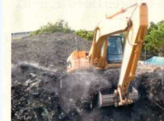
不適正処理現場の支障除去の様子
