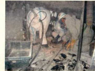
硫酸ピッチ撤去現場の様子
