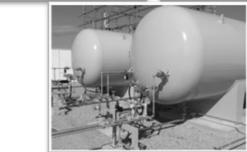
アルカリ/PEM水電解装置・水素貯蔵タンク (水素製造研究等)
