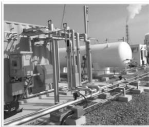
水電解装置・水素貯蔵タンク・燃料電池 (災害対応設備)
