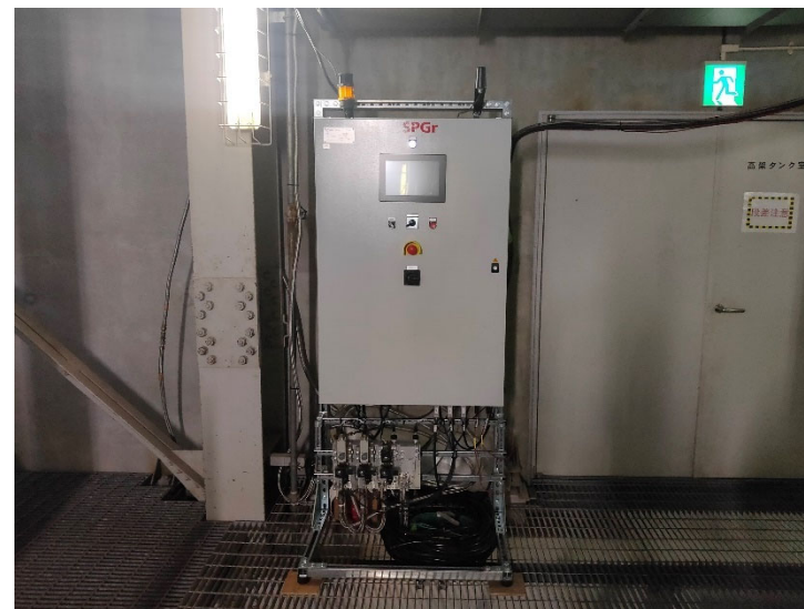
制御パネル設置
