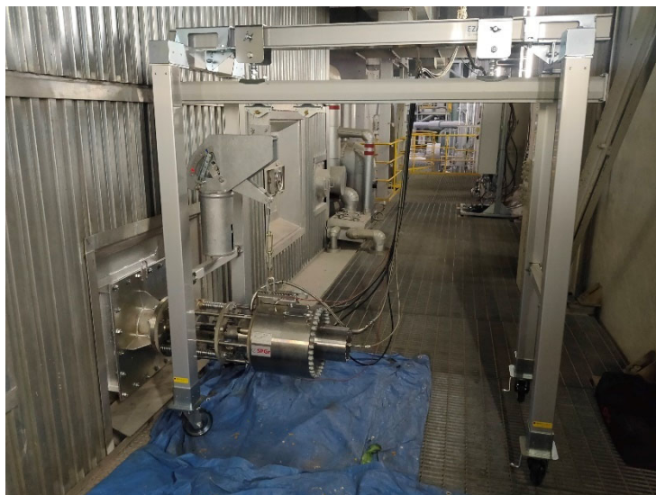
圧力波式スートブロワ設置
