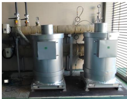
反応器取付け後の状態
