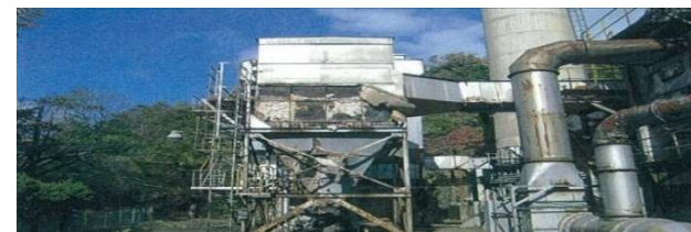
老朽化して休止した処理施設
