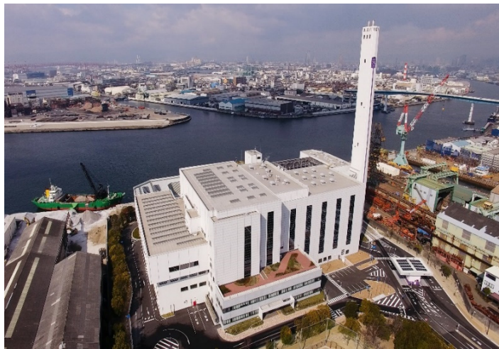
プラント外観(住之江工場資料より)
