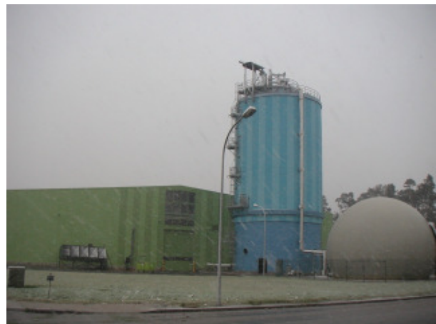
Pohlsche Heide 市の MBT 施設 緑の建物内に破碎選別施設がある。青い塔は発酵層。白い円形の容器内にメタンガスを貯留する。
